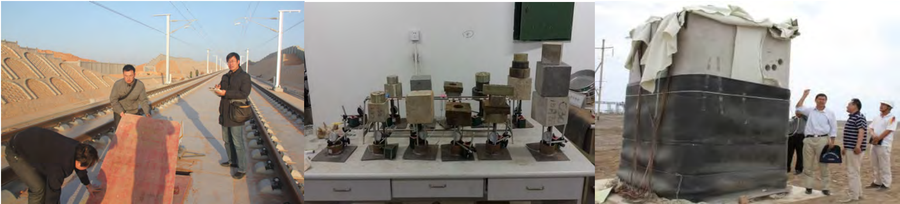
兰新高铁的施工现场
